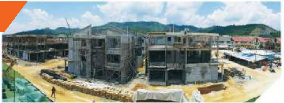
场地建筑工程继续进行，外部结构进入尾声。
